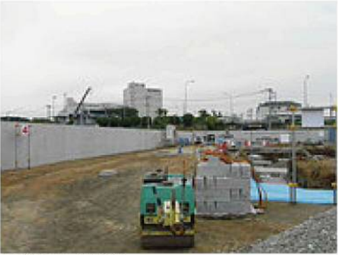
長野県内 某倉庫
