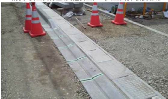
防災・安全交付金(交通安全)工事(主)駒ヶ根長谷線2
