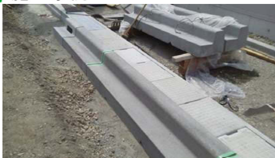
防災・安全交付金(交通安全)工事(主)駒ヶ根長谷線1
