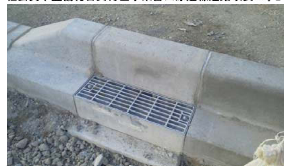
社会資本整備総合交付金事業吉田原通線道路改良工事2
