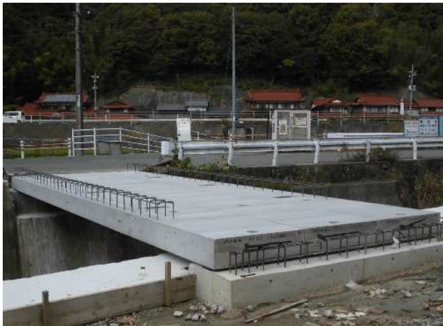
■木谷郷川 橋梁災害復旧工事（広島県）
