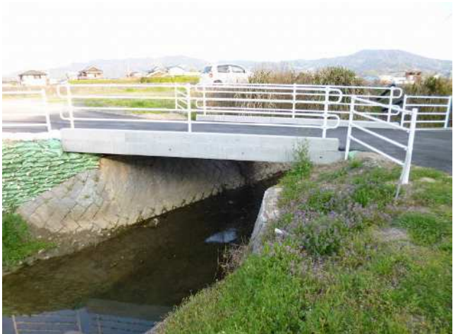
■清水橋 橋梁架け替え工事 T-14 (L)8500×(B)1000×(t)320
