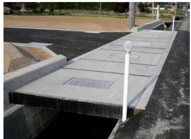
■山口市 某民間 宅地造成工事
