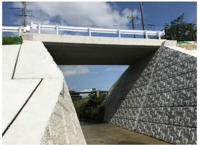
■厚狭川 河川災害 復旧工事 T-9 (L)8800 × (B)1122 × (t)320
