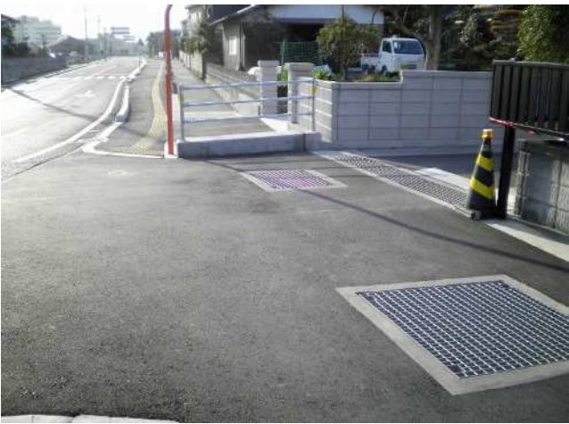
■市道くし山線 道路改良工事
