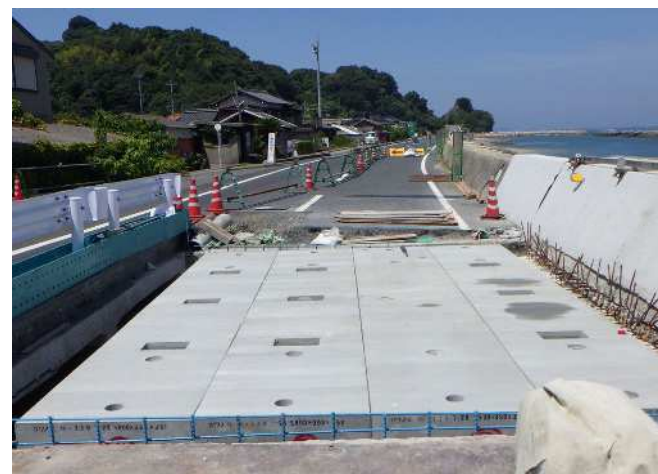
■一般国道437号 橋梁補修工事
