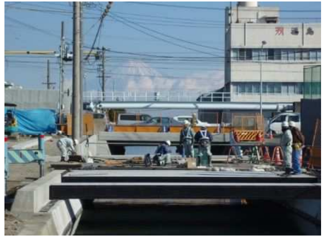
■清水駒越SC 新築工事（静岡市）
