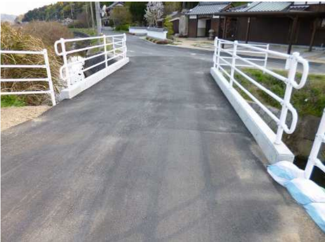
■清水橋 橋梁架け替え工事 T-14 (L)8500×(B)1000×(t)320
