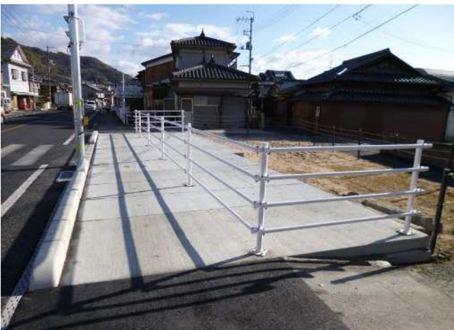
■一般県道 下松新南陽線 単独交通安全 一種工事 T-2 (L)4400×(B)1000×(t)150 等
