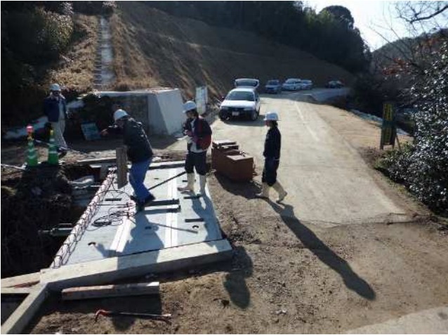
■免地東本郷線 道路改良工事
