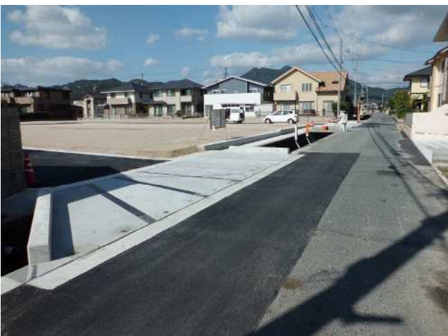
■防府市 某民間 宅地造成工事
