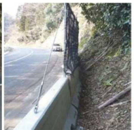
施工後：落石混じり土砂を捕捉
