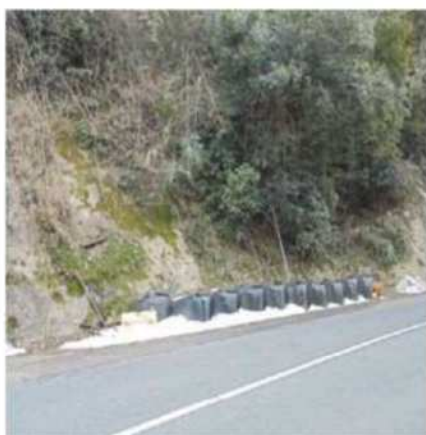
施工前：大型土のう
