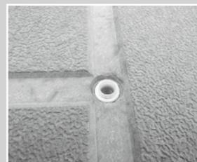
吊り用インサートを、プラスチックキャップで塞ぐ
