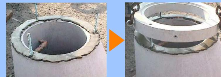
2. ボルトにナットとワッシャーをはめこみ、下ナットで受枠の高さ調整をします。モルタルを多めに敷均し、モルタルを押潰す要領で受枠を設置したら、上ナットで3ヶ所を均等に軽く締めます。
