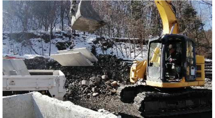
2. 専用治具でブロック本体を吊る
