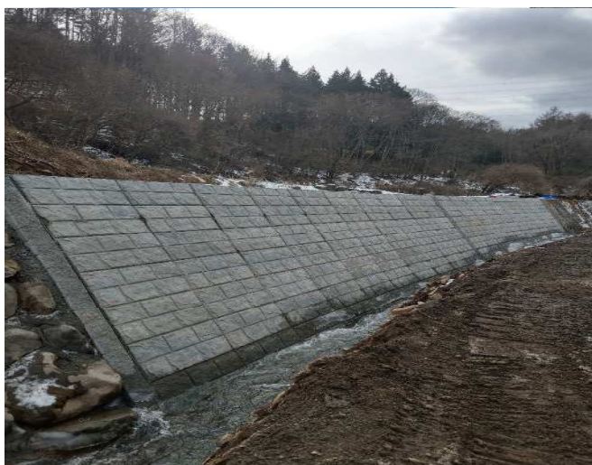
長野県小県郡長和町
