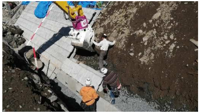
4. 裏込材を入れながら積んでいく
