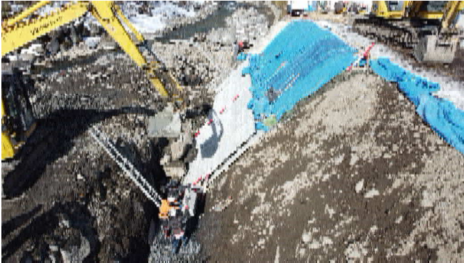
1. 基礎ブロックを据える
