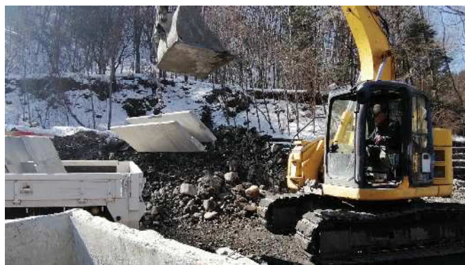
2. 専用治具でブロック本体を吊る
