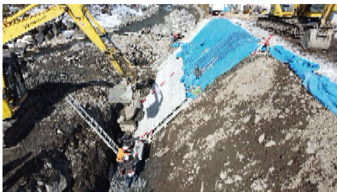
1. 基礎ブロックを据える
