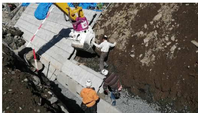
4. 裏込材を入れながら積んでいく
