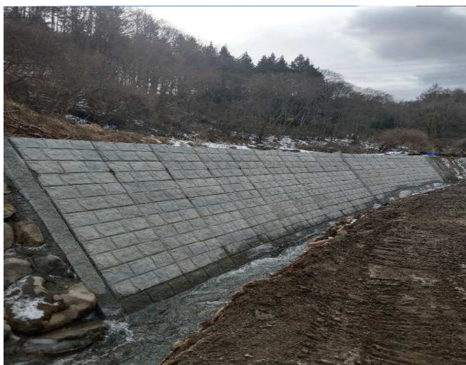
長野県小県郡長和町
