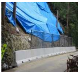
崩壊斜面下に仮設で設置
