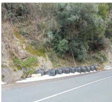
施工前：大型土のう
