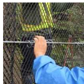
ネットジョイント設置
