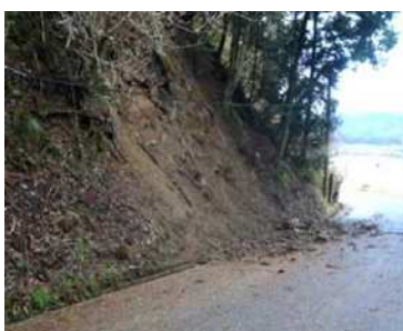
施工前：斜面崩壊
