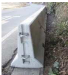
基礎擁壁の側面
