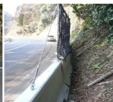
施工後：落石混じり土砂を捕捉
