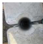
設置後に上から見た状態
