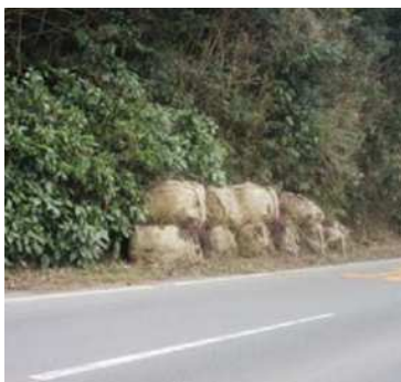
施工前：大型土のう
