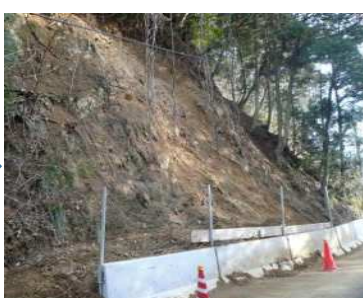
施工後：崩壊土砂を捕捉
