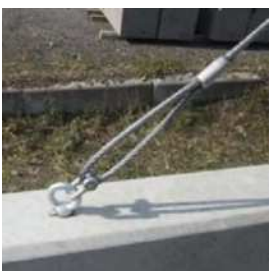
斜ロープと基礎擁壁を接続
