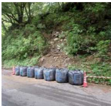
大型土のう対処事例
