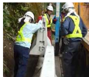
基礎擁壁の設置状況(2)
