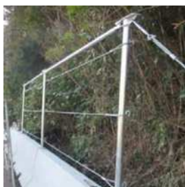
横ロープ設置完了
