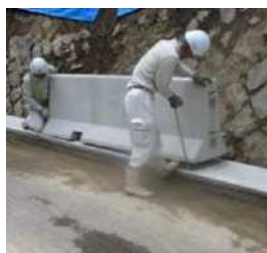
基礎擁壁の設置状況(1)
