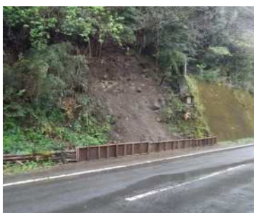
施工前：崩壊現場に仮設の木柵
