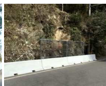
岩盤の剥離箇所に設置
