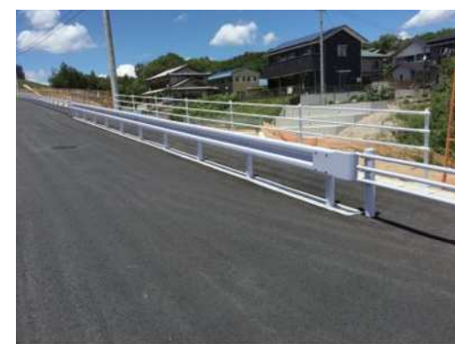
埋設利用にて施工
