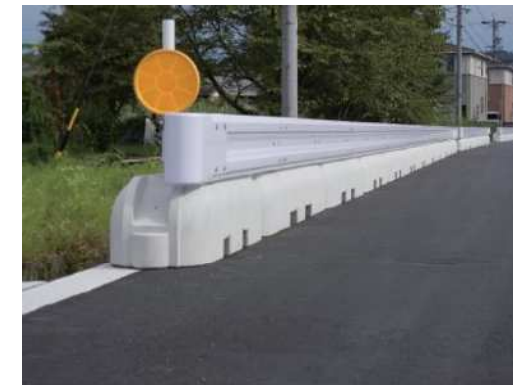
置式にて施工
