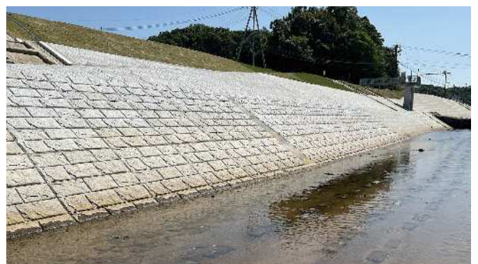
竣工後の様子 2
