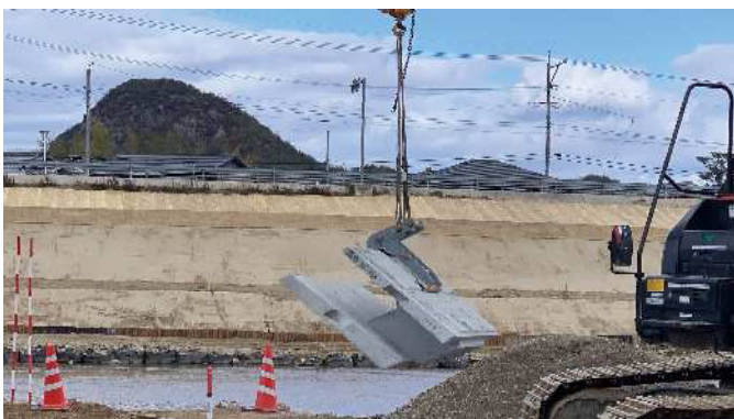
2. 専用治具でブロック本体を吊る
