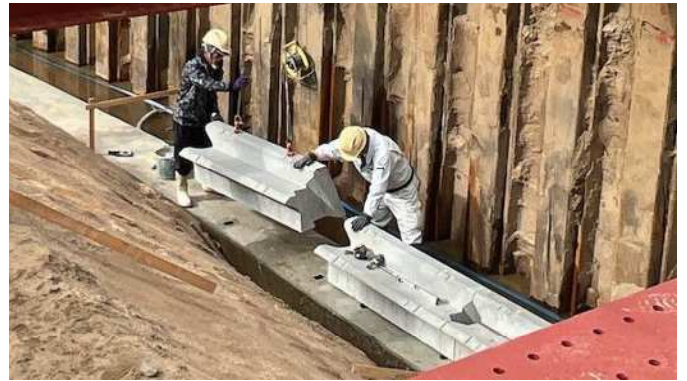
1. 基礎ブロックを据える (2)
