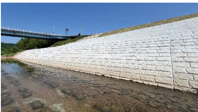
竣工後の様子 1
