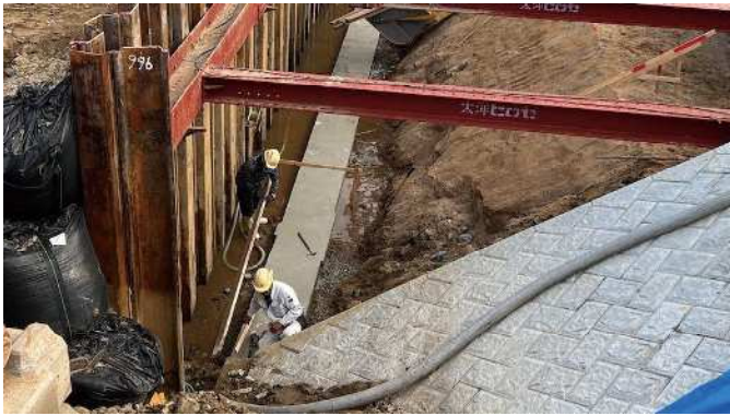
1. 基礎ブロックを据える (1)
