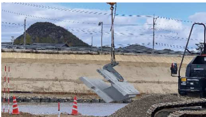
2. 専用治具でブロック本体を吊る
