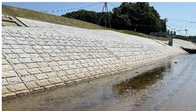
竣工後の様子 2
