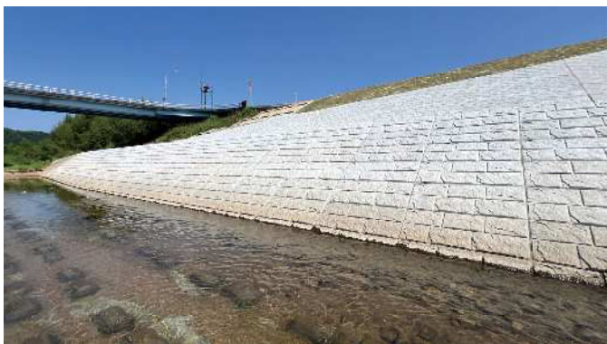
竣工後の様子 1
