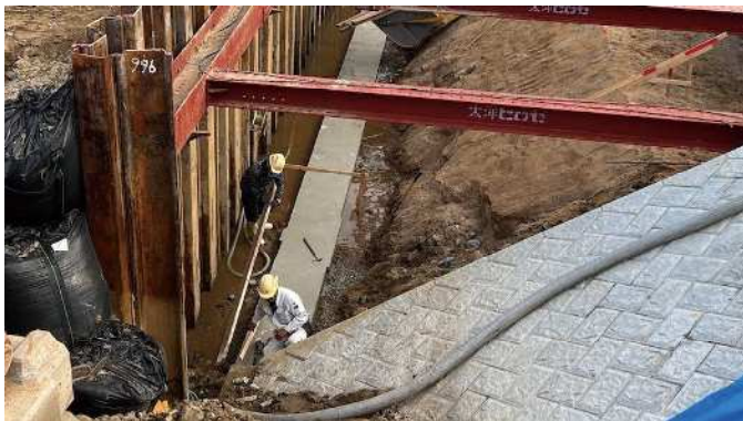
1. 基礎ブロックを据える (1)
