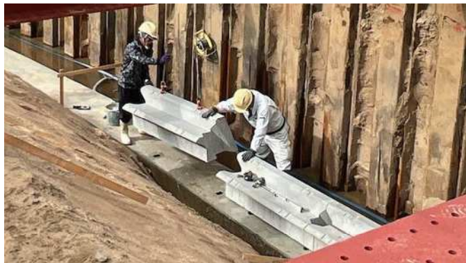
1. 基礎ブロックを据える (2)
