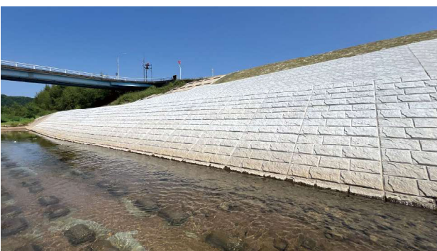
竣工後の様子 1
