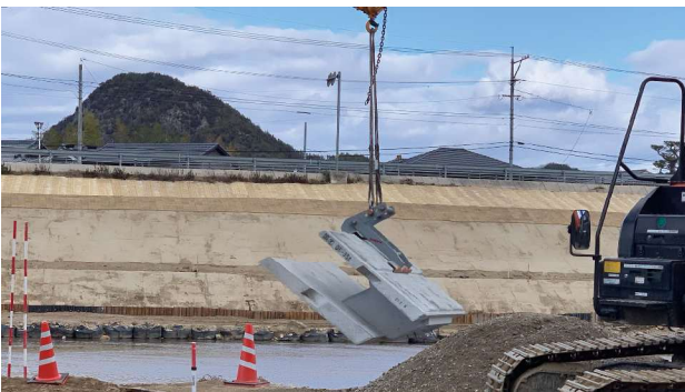
2. 専用治具でブロック本体を吊る
