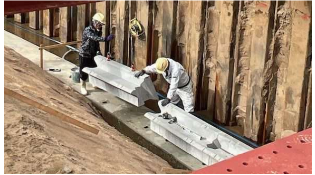
1. 基礎ブロックを据える (2)
