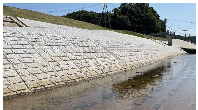
竣工後の様子 2
