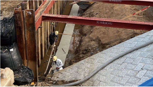
1. 基礎ブロックを据える (1)
