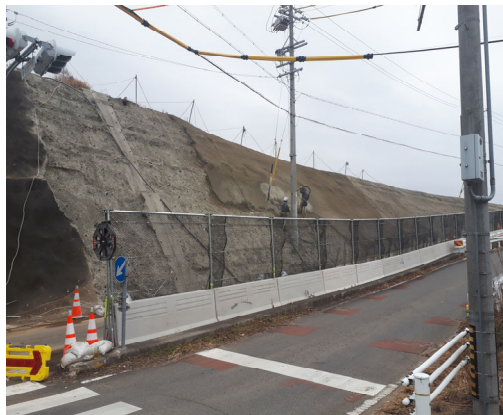
施工後:中央分離帯の内側に設置
