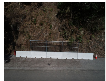
施工後 (上から)
