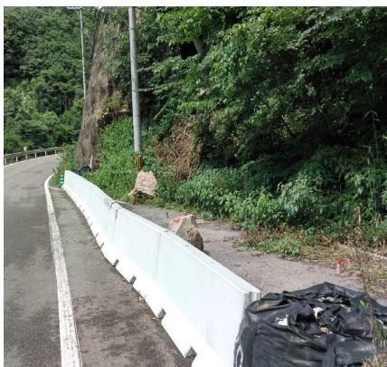
施工後1（1m程度の落石が基礎に衝突）
