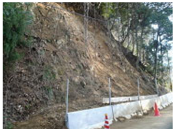
施工後（斜面崩壊が発生、土砂を受け止めた）
