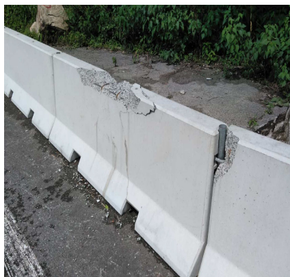
施工後2（上部、連結部が剥離した基礎）
