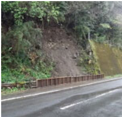
施工前（仮設に木柵）
