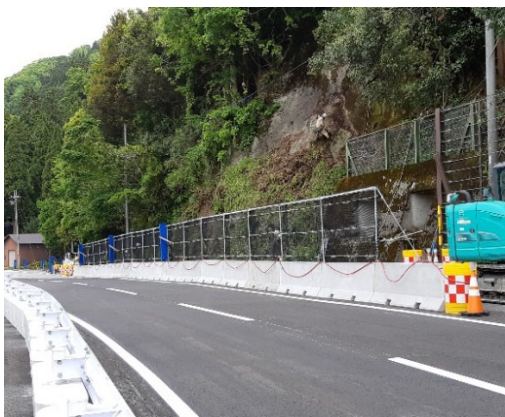
施工後:路肩に設置
