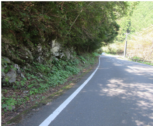
施工前（路肩に小石が落ちている）
