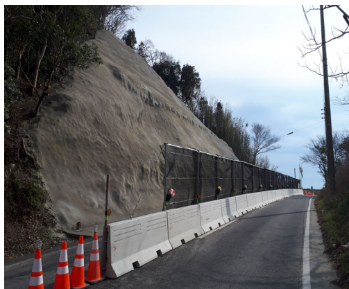
施工後:二車線道路の中央部に設置
