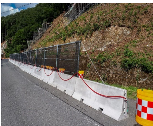
施工後:路肩に設置
