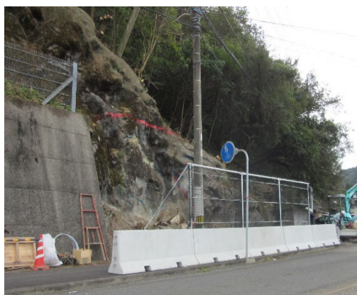
施工後:歩道端に設置
