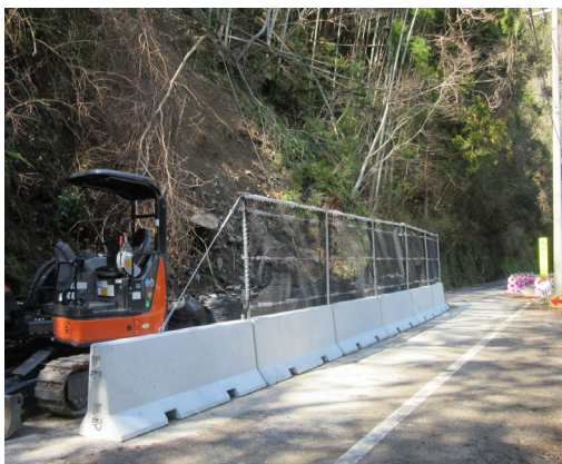
施工後:斜面側に重機が入って作業
