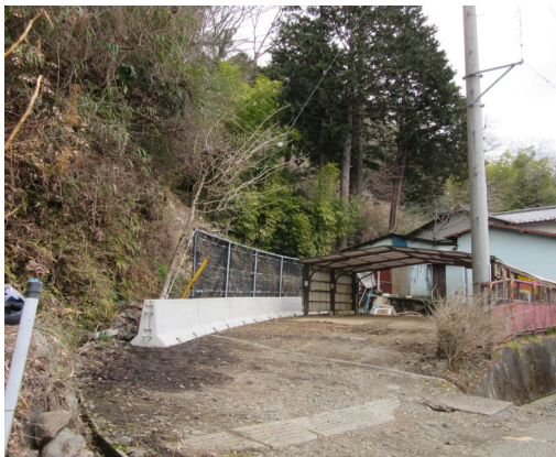
施工後:急傾斜地の民地への設置
