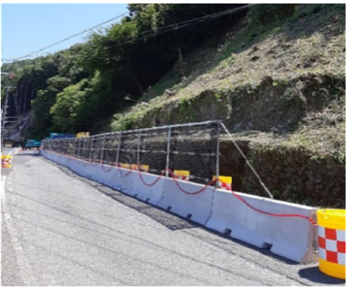
施工後:路肩に設置
