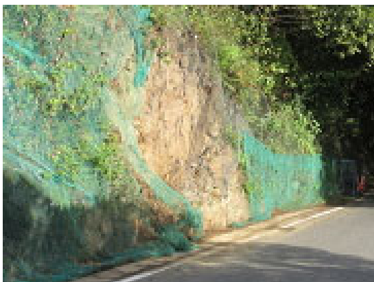
施工前（現状の斜面崩壊：網が裂けている）
