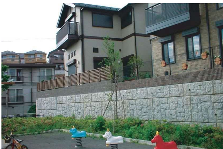
東京都町田市玉川学園 宅地造成工事
