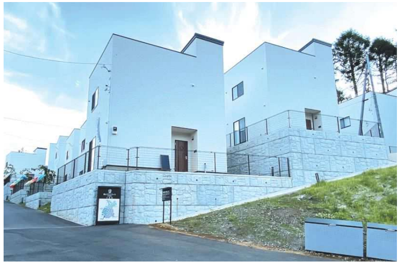
山梨県富士吉田市 宅地造成工事
