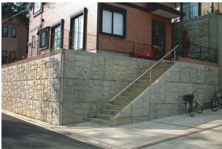
東京都町田市あかね台 宅地造成工事
