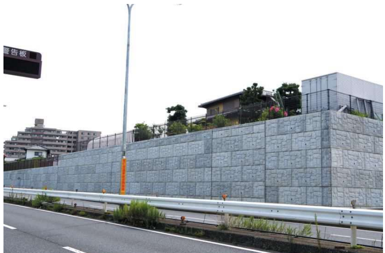
埼玉県和光市 宅地造成工事
