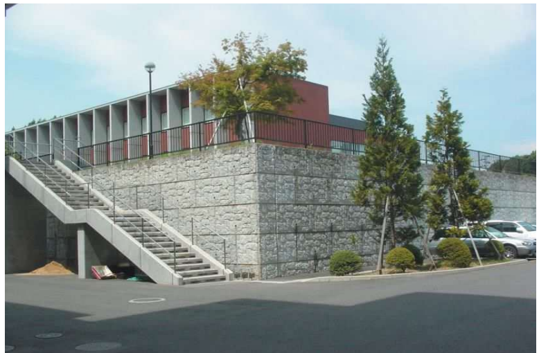
福島県白河市市 民間病院造成工事
