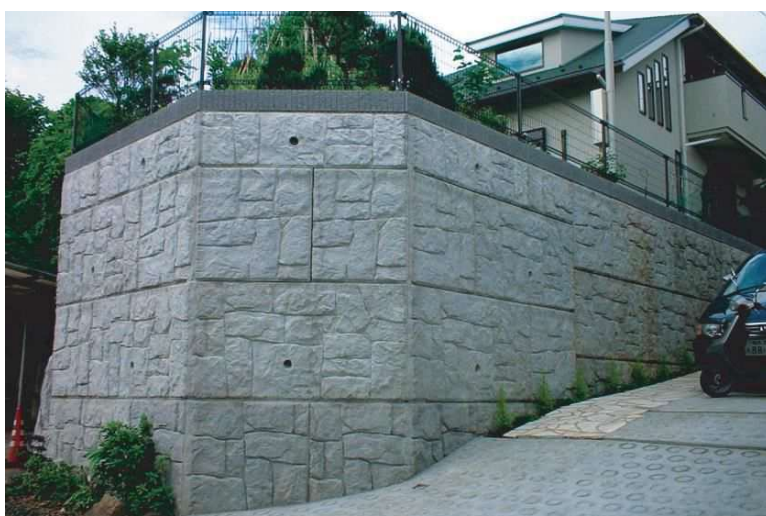
東京都町田市成瀬 宅地造成工事
